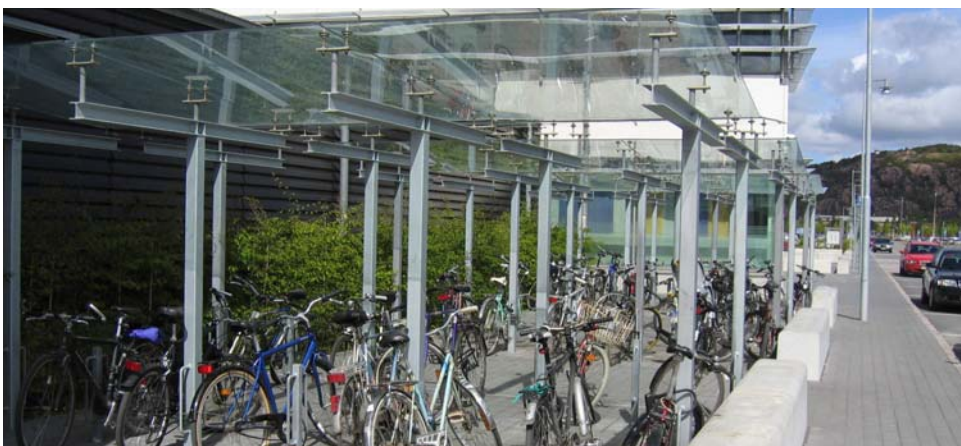
Exempel på väderskyddad heldagsparkering för anställda på Ericsson på Lindholmen i Göteborg.
