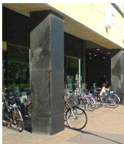
Köpcentrum Focus dagtid utanför den södra entrén. Både den södra och den västra entrén saknar cykelparkering.
